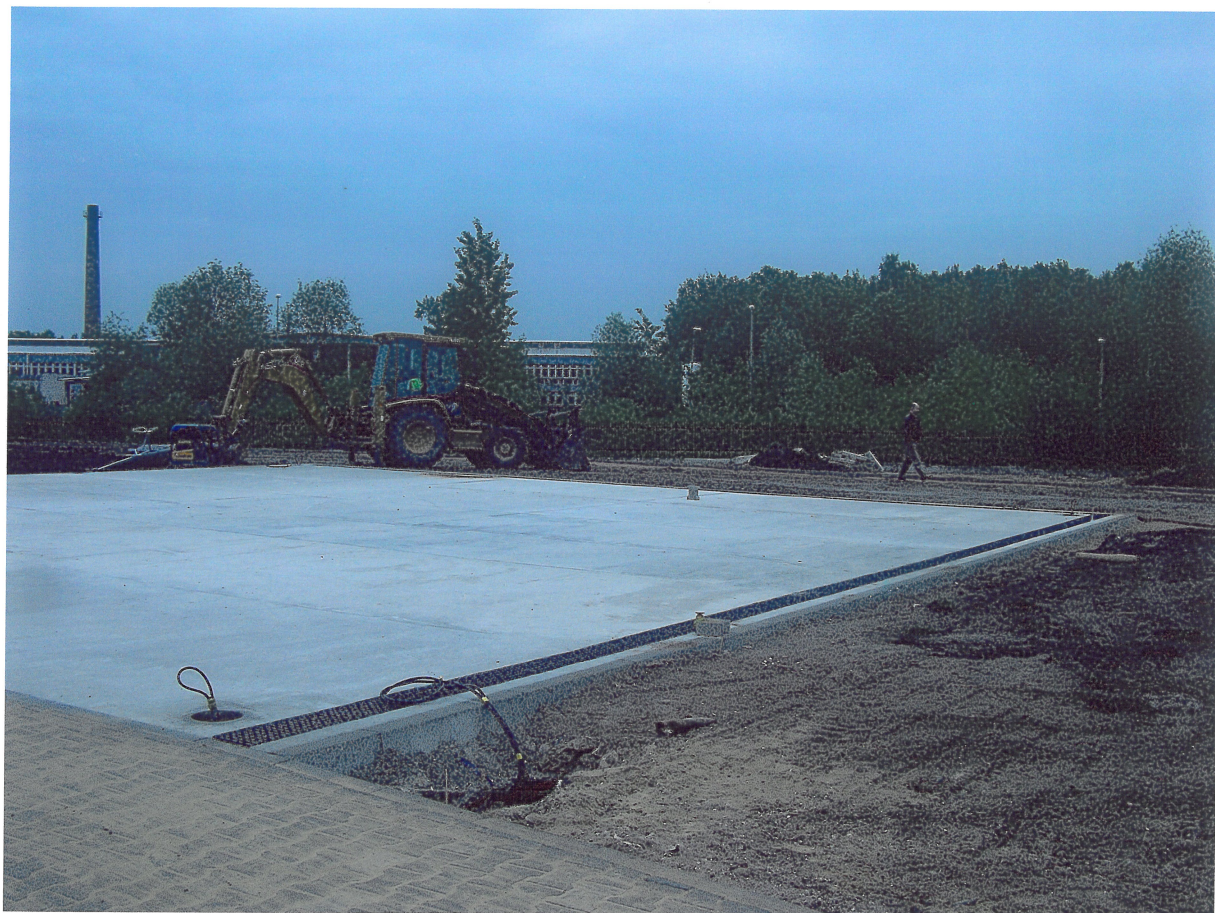
Foto archiwalne nr 1. Instalacje elektryczne – narożnik I
